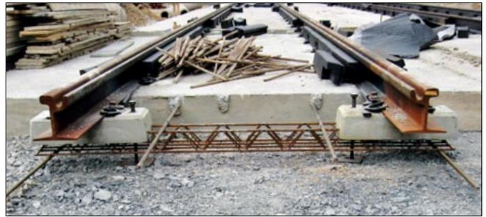
3. RHEDA-CITY-Oberbau eines Gleises mit Quer- und Längsbewehrung
