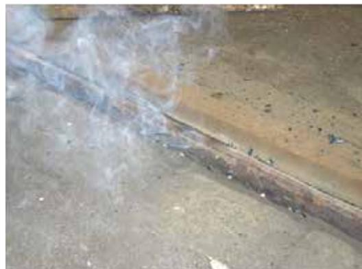
Bild 6: Schädigung des Fugenvergusses bei Auftragschweißarbeiten (Bilder: DVB AG)
